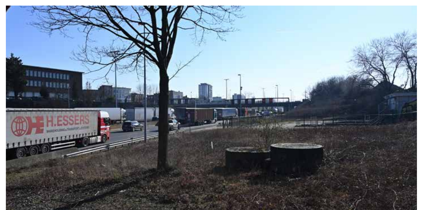
Zicht op het pompgebouw vandaag. © Stad Antwerpen
