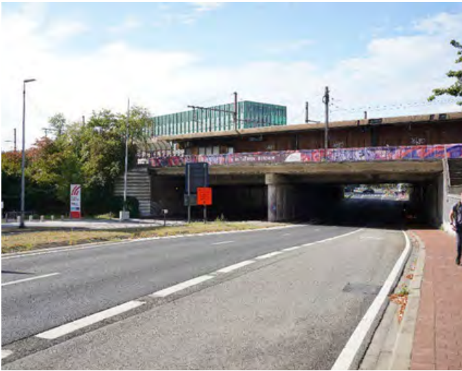
Fig. 11 - De Singelonderdoorgang onder de spoorweg
